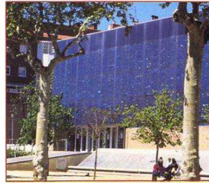
1 Panneaux photovoltaïques sur la façade Sud de la bibliothèque de Mataro (Espagne) (Architecte Miquel Brullet).
