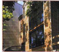
Maison individuelle à Haute Qualité Environnementale située à Neuilly-sur-Seine (France) (Architecte Bruno Boschetti).
